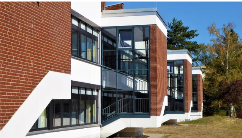
Ansicht Treppenhäuser „Schustertyp“, 2018. Foto: T. Krahn
