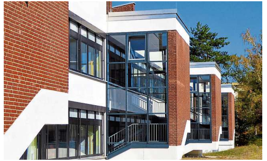
Markante Erscheinung: Die Treppenhaus-Front im ARS-Seitenflügel. Der sogenannte „Schuertyp“ gelangte zur Umsetzung. Die Treppen sind aus der Gebäude-Kubatur herausgebaut, sodass zwischen den Klassenräumen ein ebener, quadratischer Flurbereich entsteht, der bei Bedarf ebenfalls für Unterrichtszwecke genutzt werden kann.
