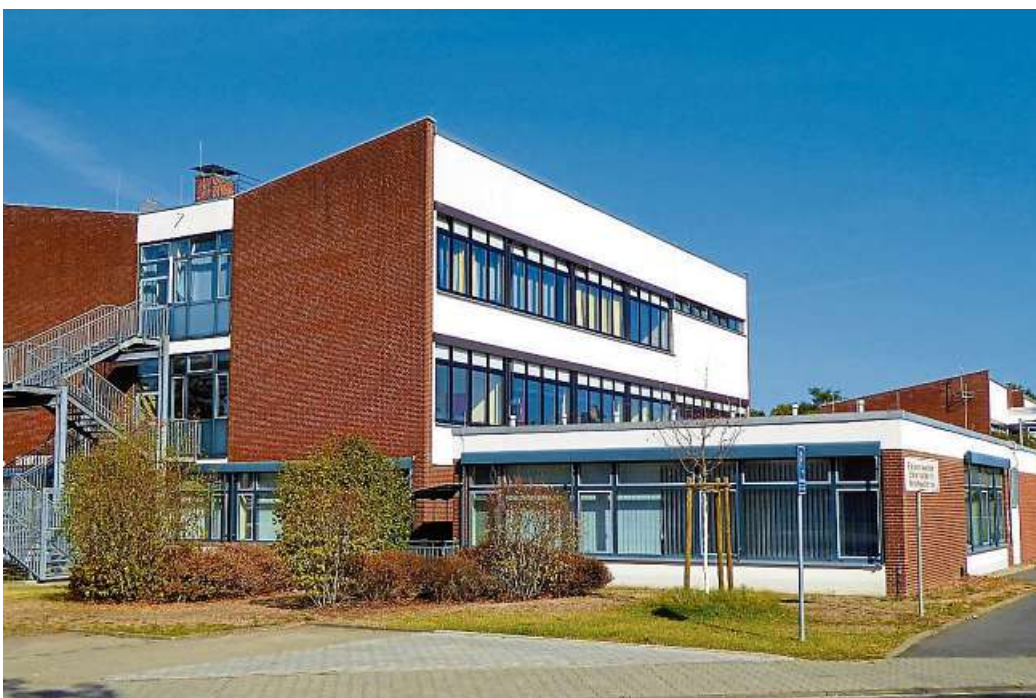
Ein vertrauter Anblick für viele Heusenstammer, die dort in den zurückliegenden fünf Jahrzehnten zur Schule gegangen sind: Das ARS-Hauptgebäude an der Leibnizstraße.
